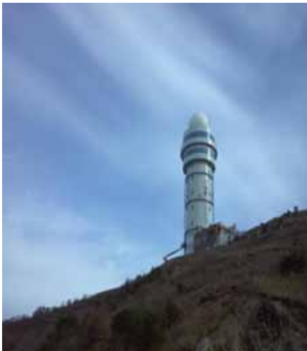
[사진 2-9] 소백산 강우레이더 관측소 전경 (출처 : 국토교통부 보도자료)
